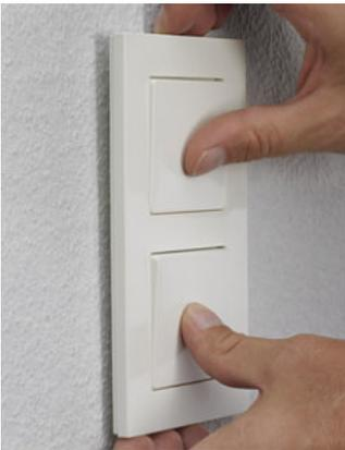
Wippe und Rahmen werden zu einer Einheit zusammengeschnappt. Aufstecken der Kombination Wippe/Rahmen auf den Geräteeinsatz – Fertig.
